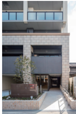
〈スロープ・手すり〉
